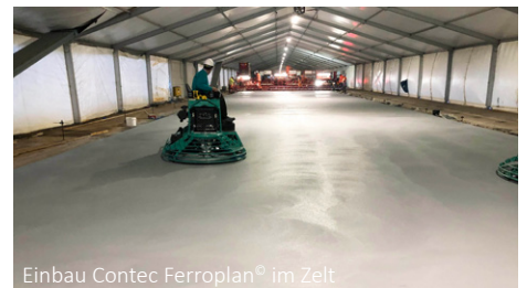
Einbau Contec Ferroplan® im Zelt
