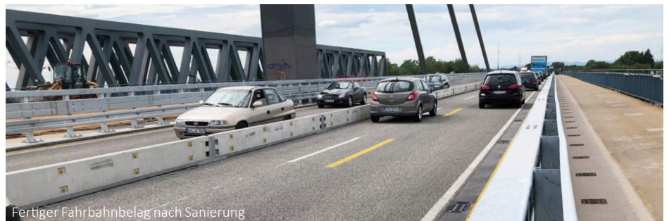
Fertiger Fahrbahnbelag nach Sanierung
