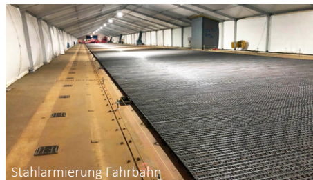
Stahlarmerung Fahrbahn
